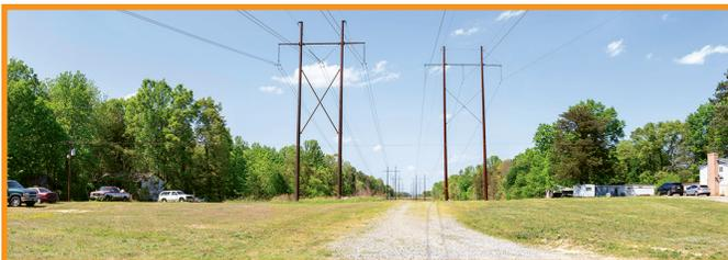
*Corredor 3 existente: Las estructuras en H (a la izquierda) serán sustituidas por nuevas estructuras monoposte. No se sustituirán las estructuras de la derecha.*
