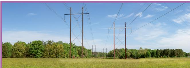
*Corredor 2 existente: Las estructuras en H (a la izquierda) serán sustituidas por nuevas estructuras monoposte. No se sustituirán las estructuras de la derecha.*
